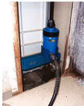
撤去時の振動・騒音の低減 手動ジャッキ工法
