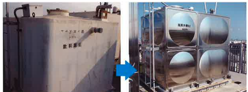
FRP製パネルタンクをステンレス溶接パネルタンクに改修した例 雑用水水槽の設置場所であったスペースを活用して高置水槽を改修
