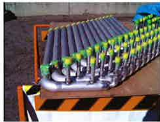
ステンレス加工管を使用した改修工事
