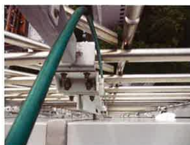
超高層マンション高圧洗浄ホースを外部立ち上げ
