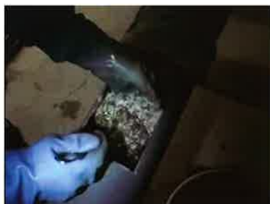
ディスポーザ系統排水管 卵殻・貝殻の堆積
