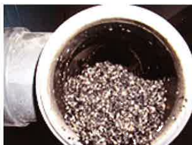
ディスポーザ系統排水管 卵殻・貝殻の堆積
