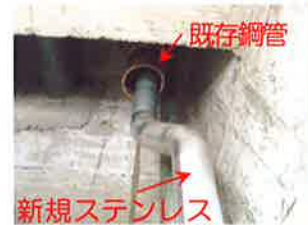
既存鋼管をスリーブとして活用した改修工事
