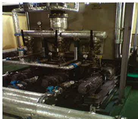
高層用給水ポンプユニット 特殊専用部品が多く使用されています
