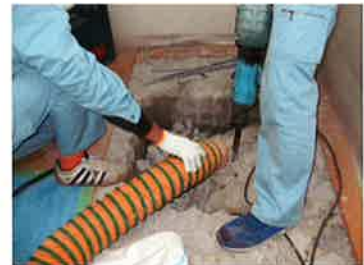
内装工事費と入室工事時間を低減する点検口の設置
