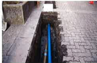
耐震性、防食性を考慮して樹脂管を使用した改修工事
