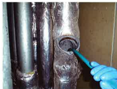
立て管の掃除口より高圧洗浄による清掃
