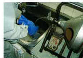
流し排水管より清掃中
