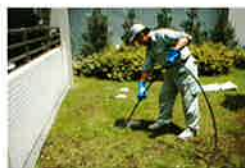
外部排水管清掃中
