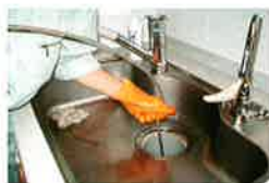
流し排水管内清掃中
