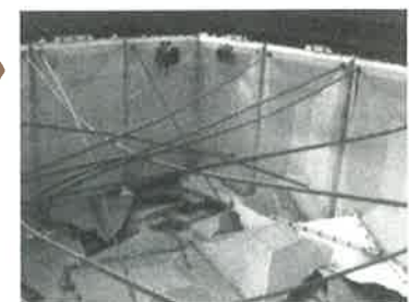
● 飲料水用受水槽の破損防止
